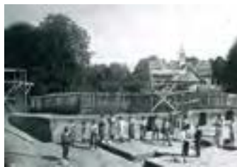
1902: Aushubarbeiten zum neuen Kloster; dahinter das Klösterl
