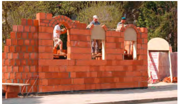
Die Mauern werden hochgezogen
