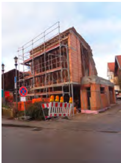
Strittiger Neubau an der unteren Traubinger Straße
