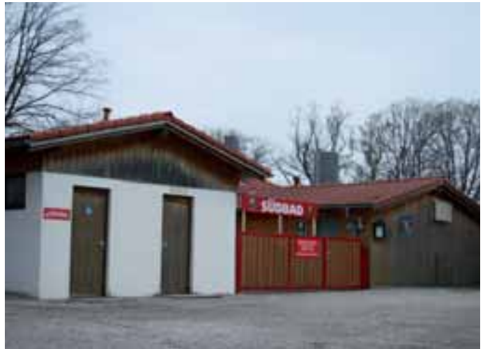
Innen und außen in Schuss - das Südbad
