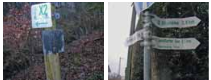
Beschädigungen: Im Martelsgraben Am Zugang zum Martelsgraben
