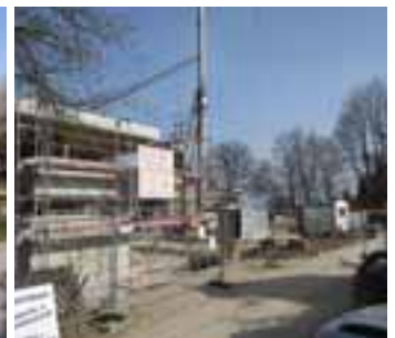
Am Höhenrain / Beiselestraße, Großbaustelle mit vielen Häusern
