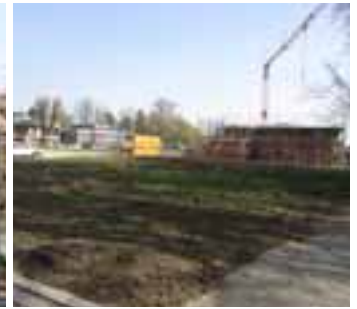
Lindlwiese, 3 Häuser im Bau, Gesamtareal vorbereitet für weitere 13 Häuser
