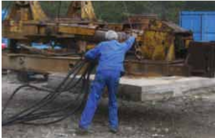
Einrichten der Bohrstelle am Pfaffenberg
