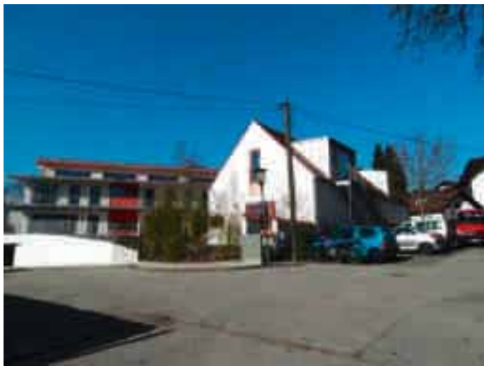
Das neue Kinderhaus in Tutzings Ortsmitte
