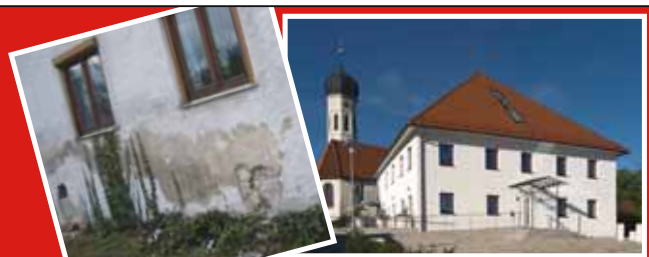
Sanierung Altes Pfarrhaus Pöcking
