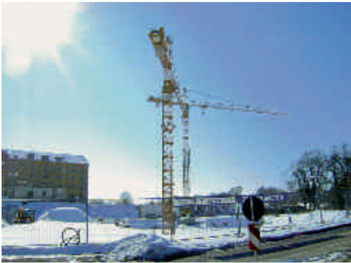
Großbaustelle Tutzing-Süd: Wachstum wohin?
