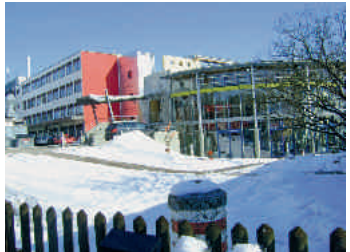
Renoviertes Bürogebäude mit Eventrotunde: Attraktiver Standort
