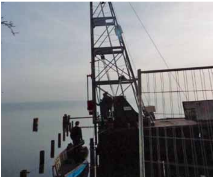
Arbeiten am Tutzinger Dampfersteg: Rüsten für die Sommersaison
